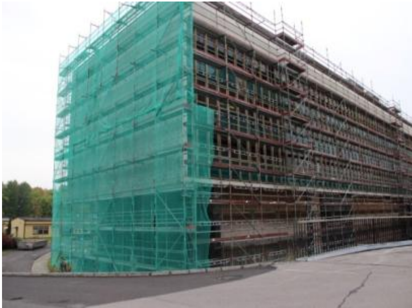
工事中の状況 (C棟)
