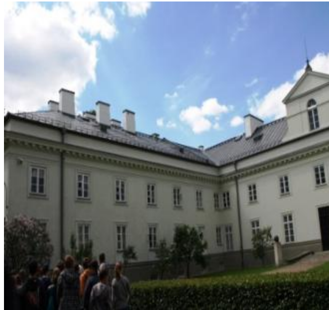
屋根断熱を施工済みの管理事務所 (2012年5月18日撮影)
