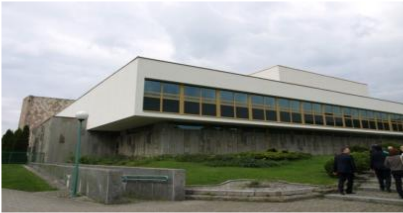
断熱窓断熱ガラスに交換されたA棟の外観（2013年5月13日撮影）
