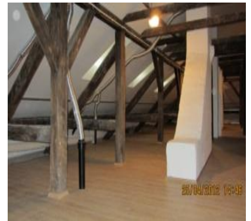
断熱施工された屋根裏
