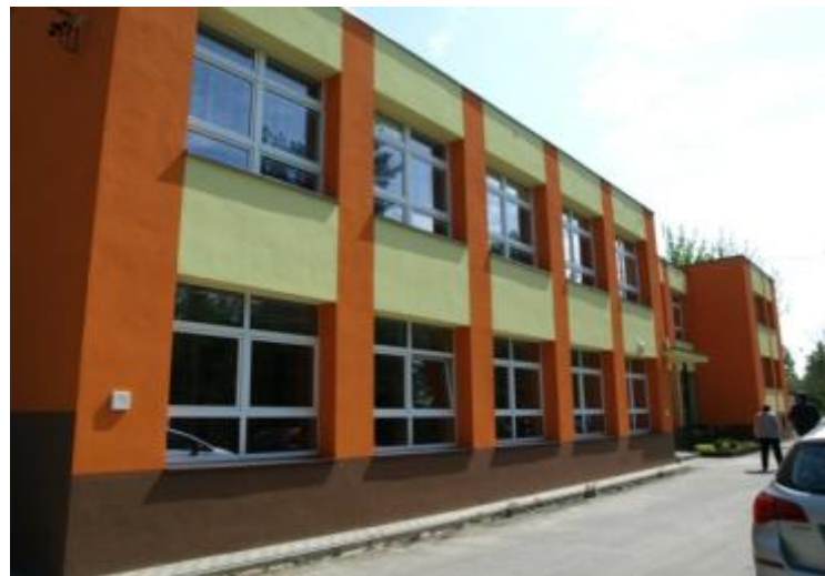
工事完了後の状況(2013年5月13日撮影)
