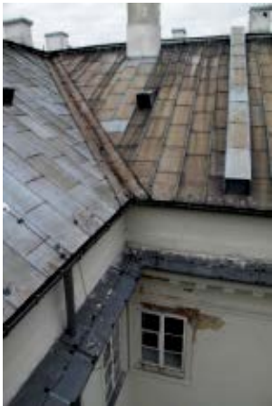
改修前の状況
