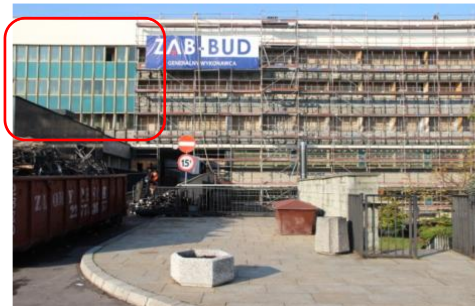
工事中の状況 (B棟)
