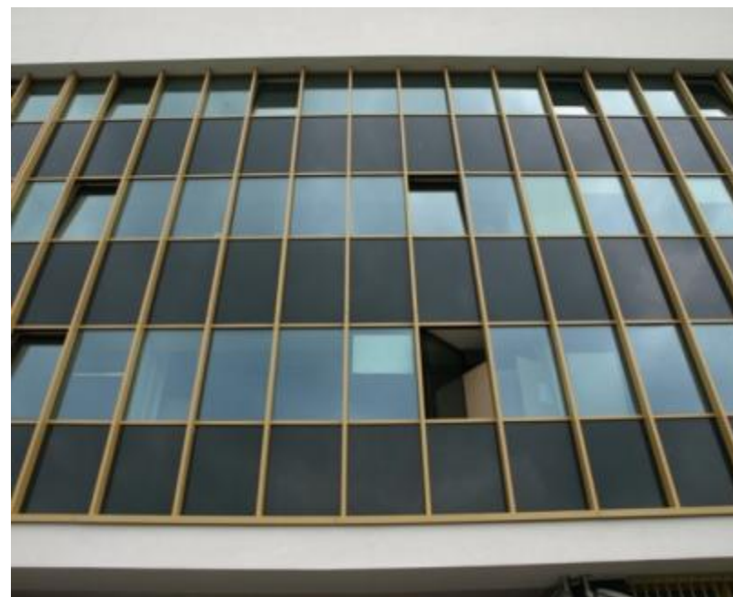
断熱窓ガラスを交換済みのB棟 (2013年5月13日撮影)
