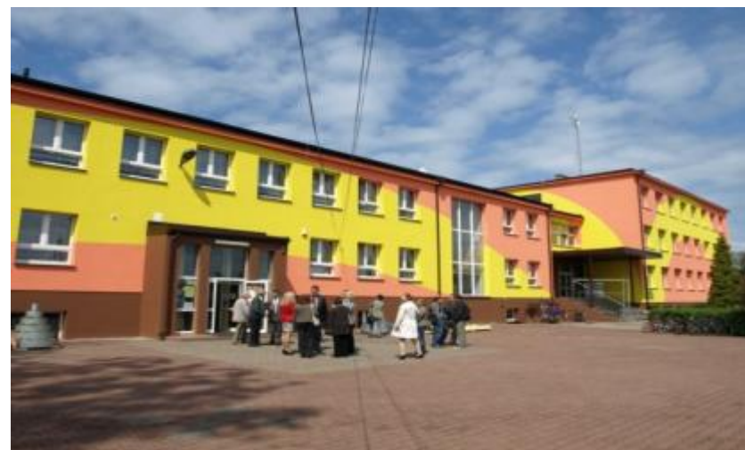
工事完了後の状況(2013年5月13日撮影)
